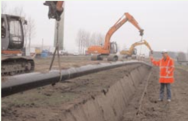
Werkzaamheden aan het CO 2 -leidingnet van OCAP langs de Nieuwesluisweg in Rotterdam
